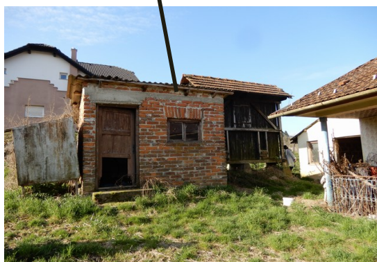
Pomoćna zgrada - spremište
