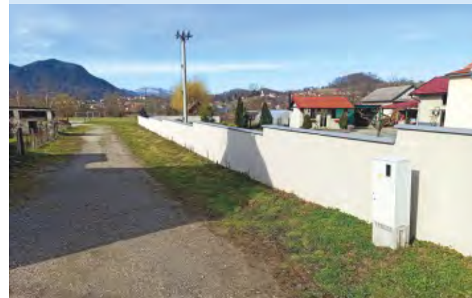
Dječje igralište Krušljevec – priključak električne energije
