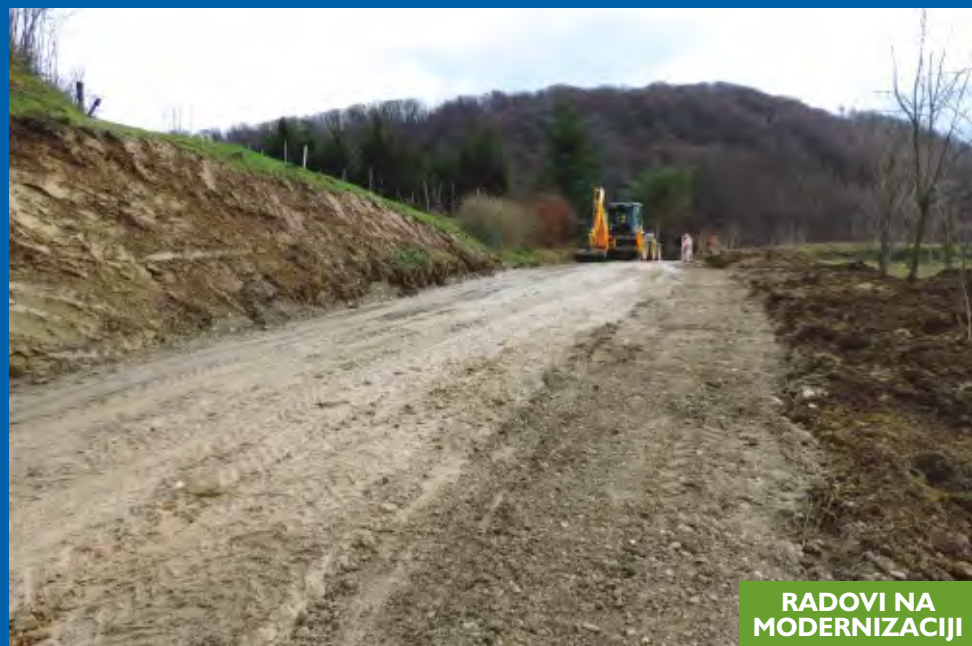
RADOVI NA MODERNIZACIJI
