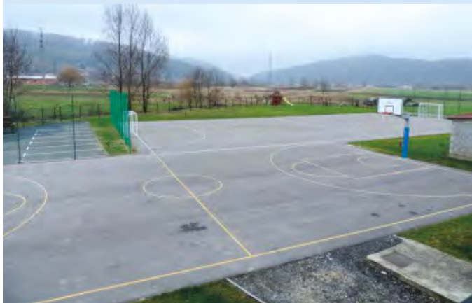
Dječje igralište u Beletincu – asfaltiranje malonogometnog i košarkaškog igrališta, postava zaštitne ograde, koševa i golova
