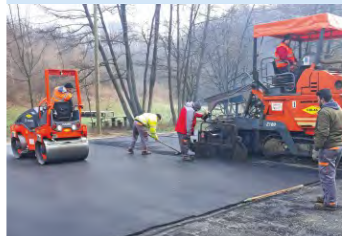
Dječje igralište u Slugovinama – asfaltiranje košarkaškog igrališta, postava koša, priključak električne energije
