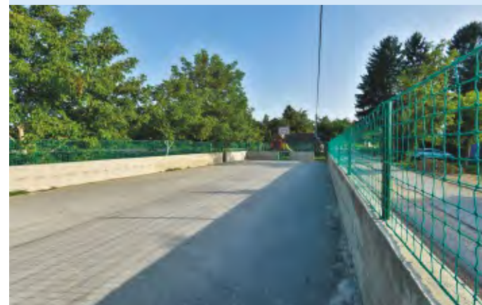
Dječje igralište u Žigrovcu – izgradnja mantinela, postava zaštitne ograde, golova i rasvjete
