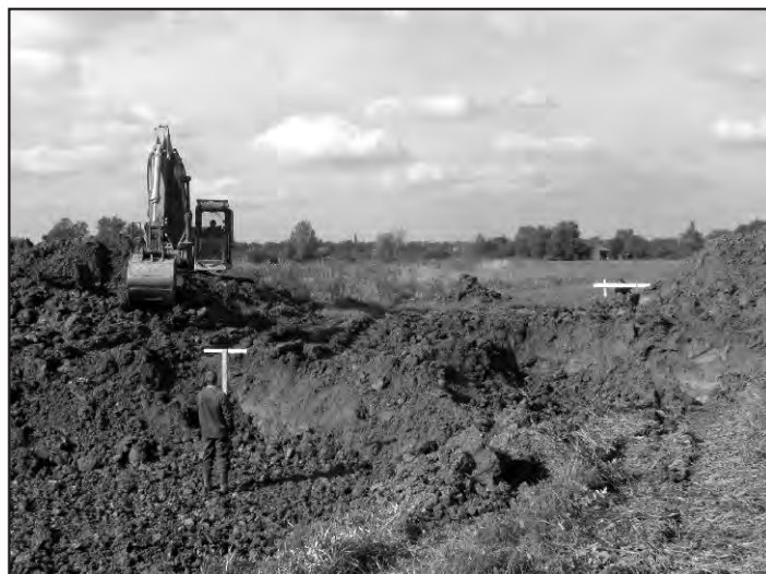
Listopad 2010. – Početak radova na izgradnji biljnog pročišćivača u Svetom Iliji
