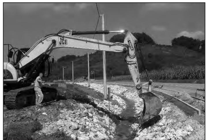
Izgradnja nogostupa u Beletincu
